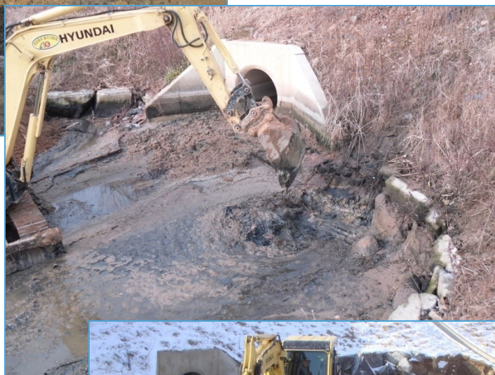
<底泥疏浚现场>
