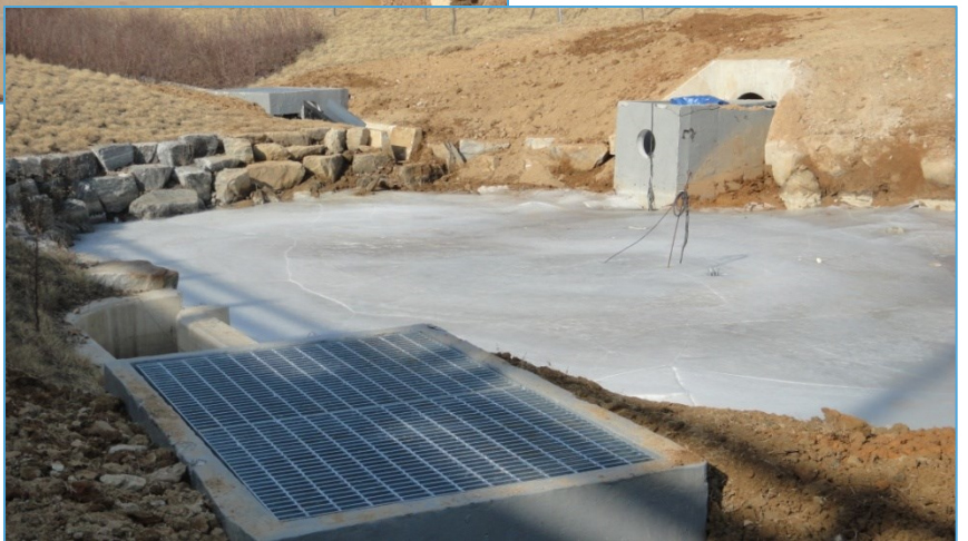
<仁川大桥 植被非点污染油槽型的装置>
