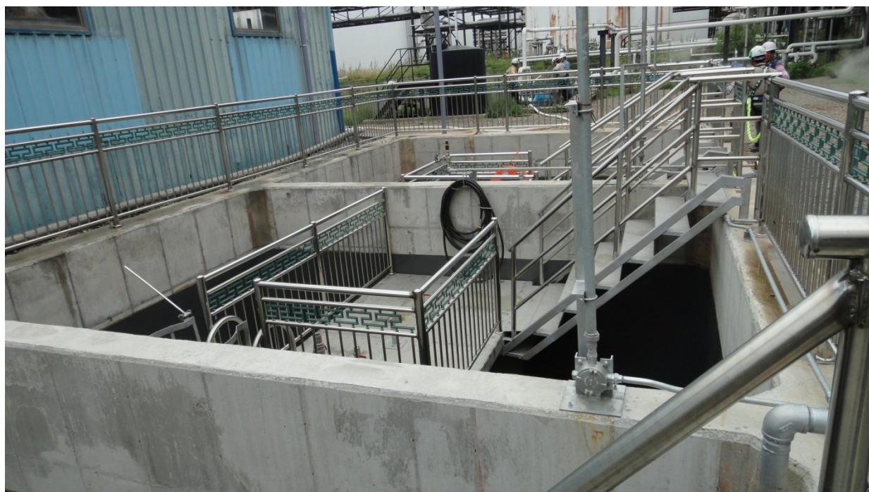
<AOS SEPARATOR 安装 全景>
