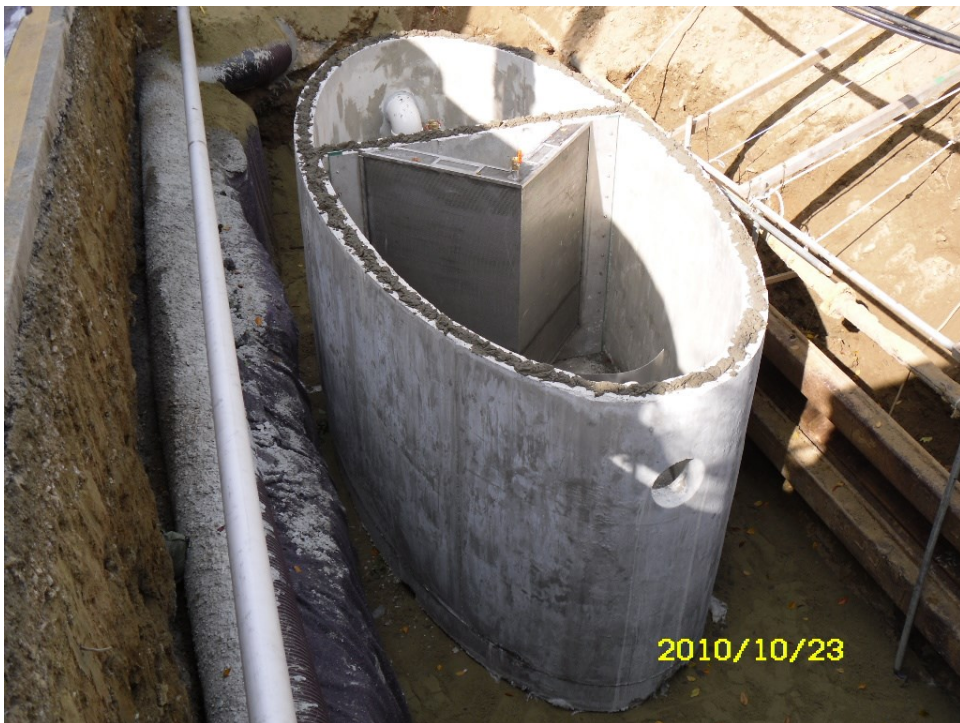
AOS SEPARATOR 施工场面
