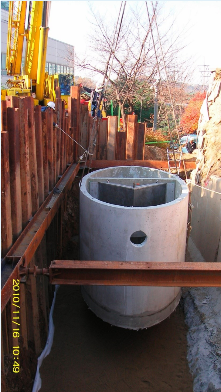
<处理设施 本体 安装>
