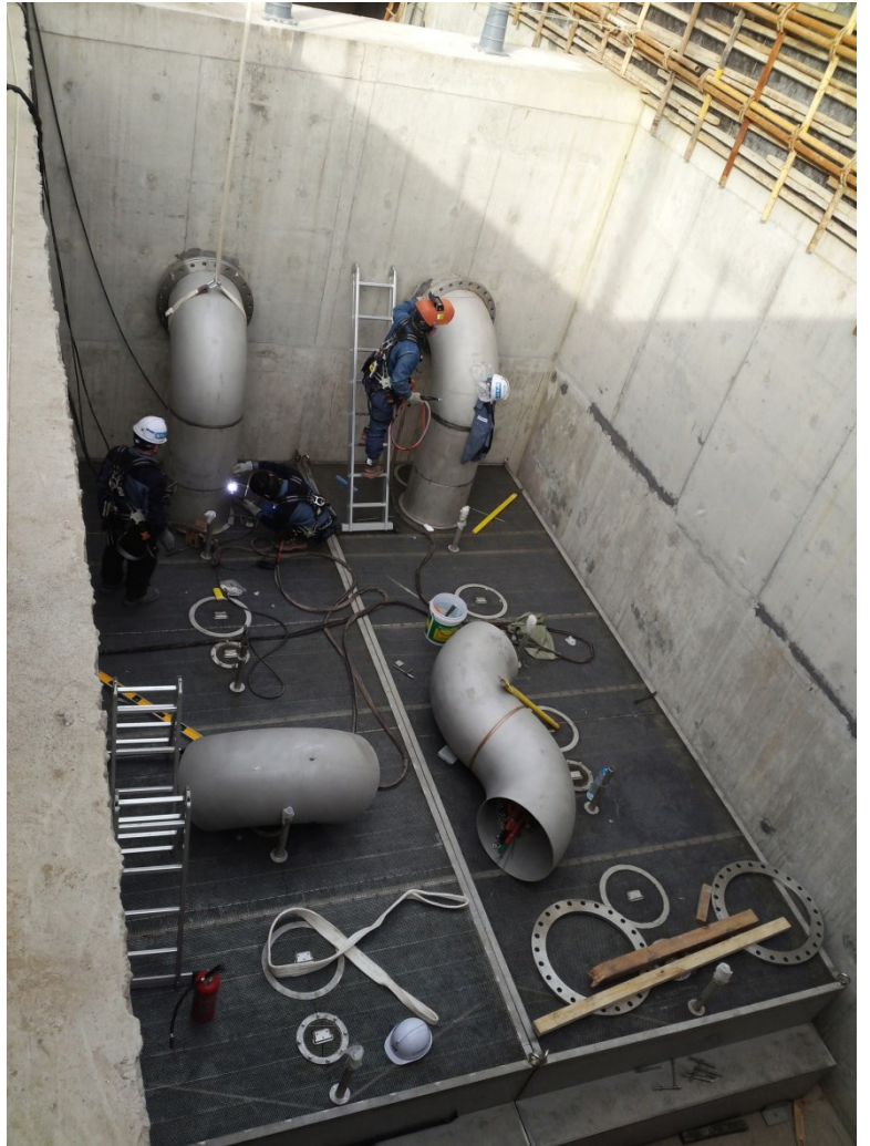
<AOS SEPARATOR 安装>
