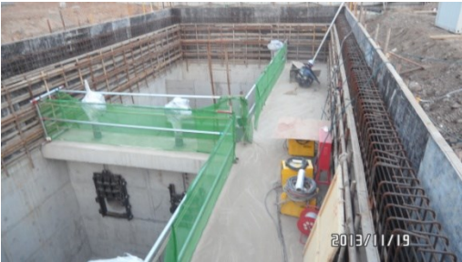
<电动水门 安装>
