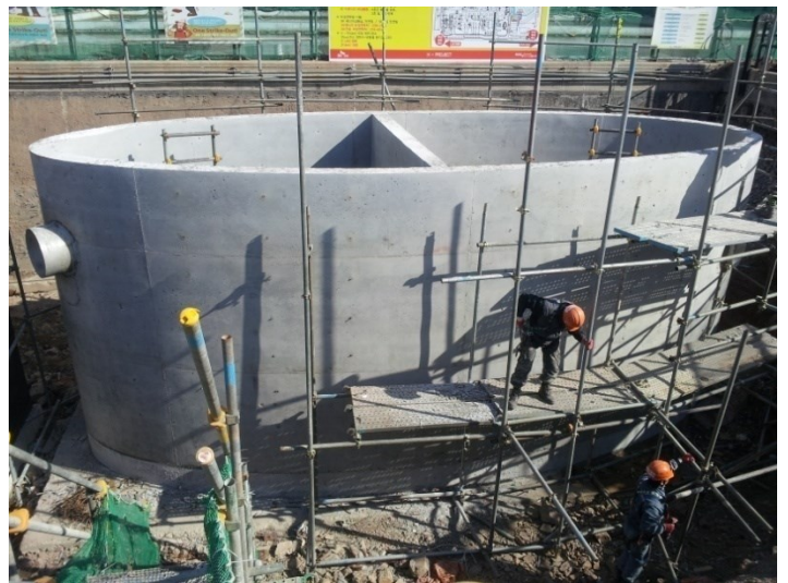
<AOS SEPARATOR 的唯一的 椭圆形 构造物 安装>
