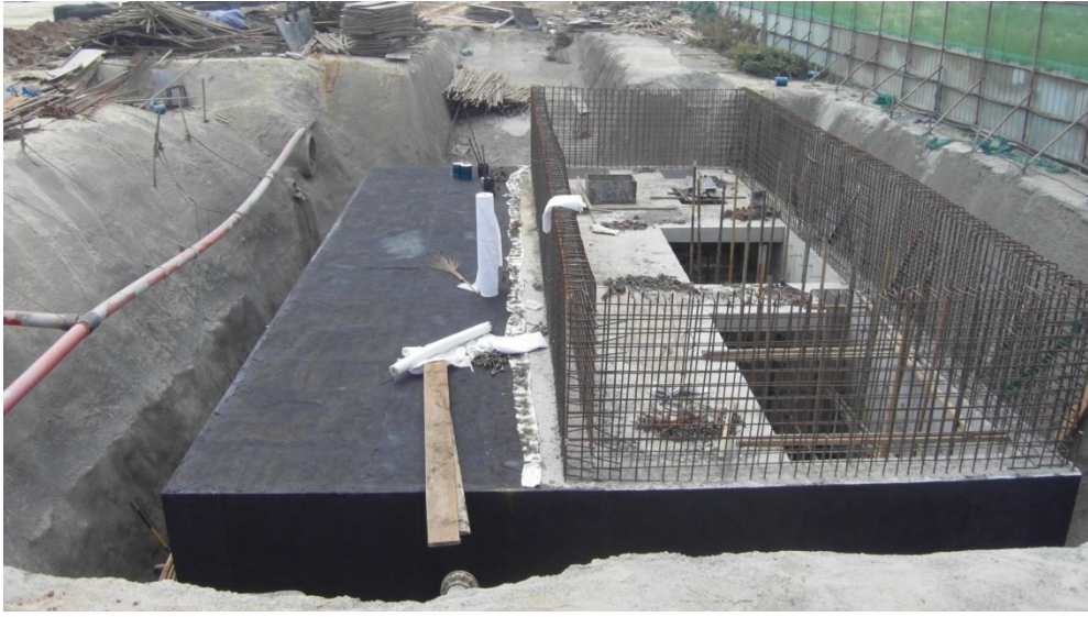
<AOS SEPARATOR 构造物 安装工程>
