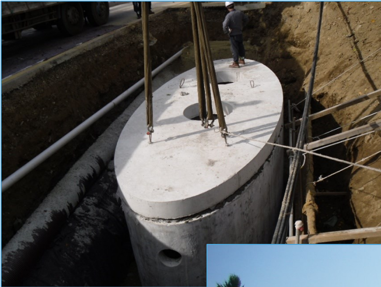
← <AOS SEPARATOR处理设施主体安装>
