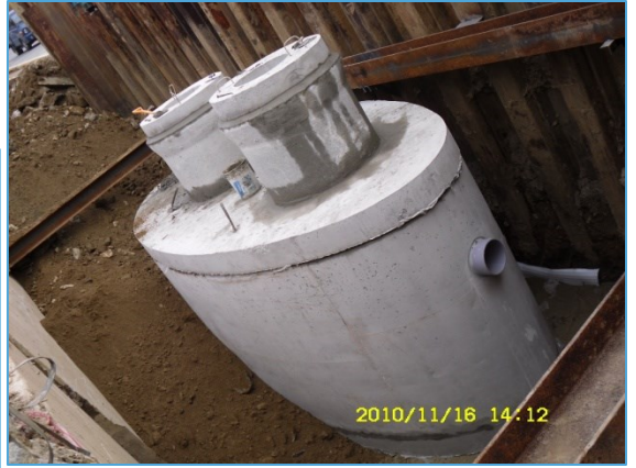
<检验区 安装 及 回填>
