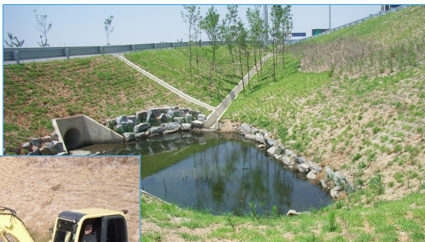
<施工前 污染的植被水库场面>
