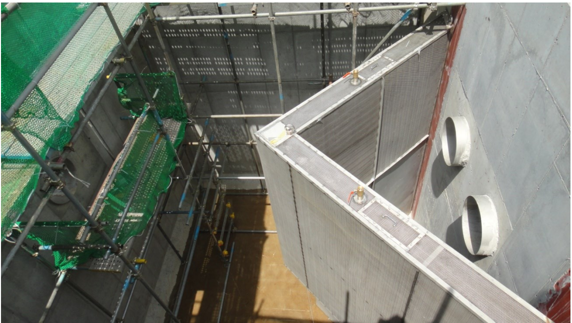
AOS SEPARATOR 施工现场 (SK 能源 )
