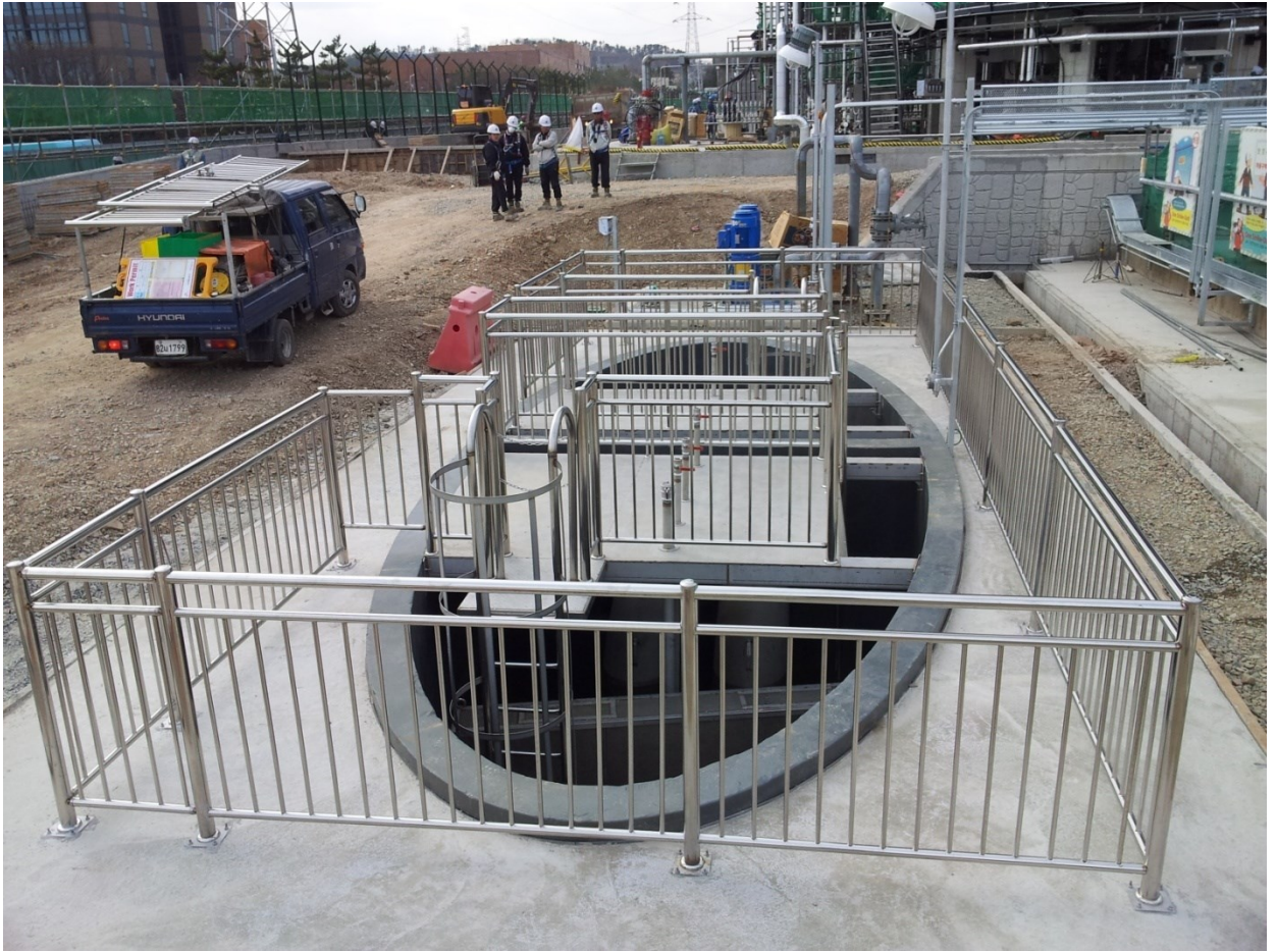
<AOS SEPARATOR 安装 全景>
