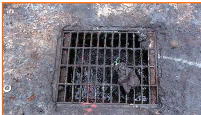
<汚染物質 排出 実例>
