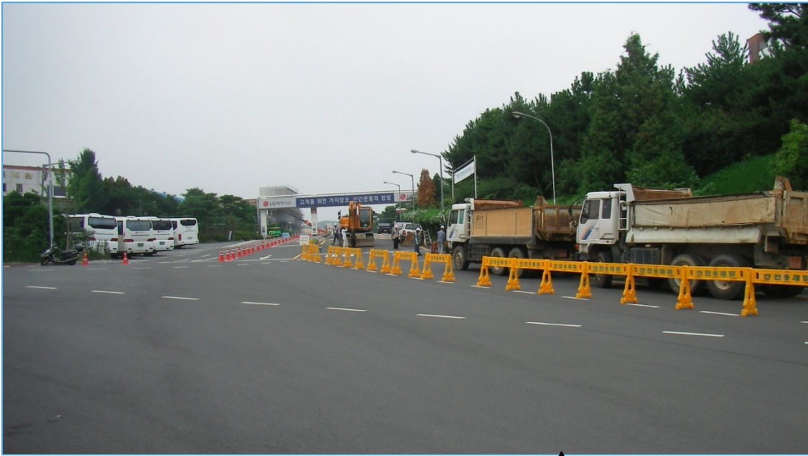
↑ <공사 현장 전경>
