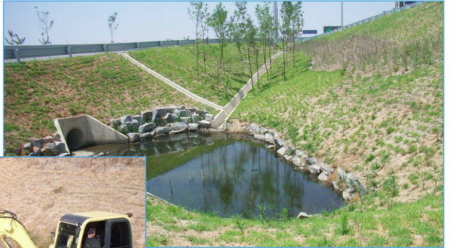
<공사전 오염된 식생저류조 장면>
