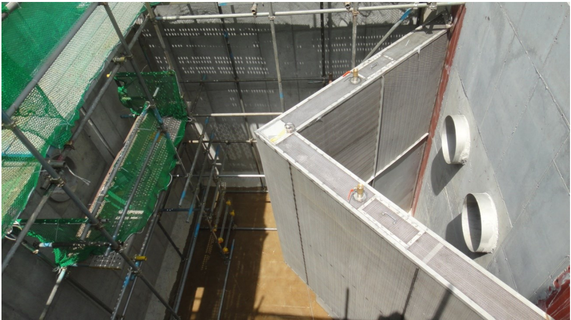
AOS SEPARATOR 시공장면 (SK 에너지)
