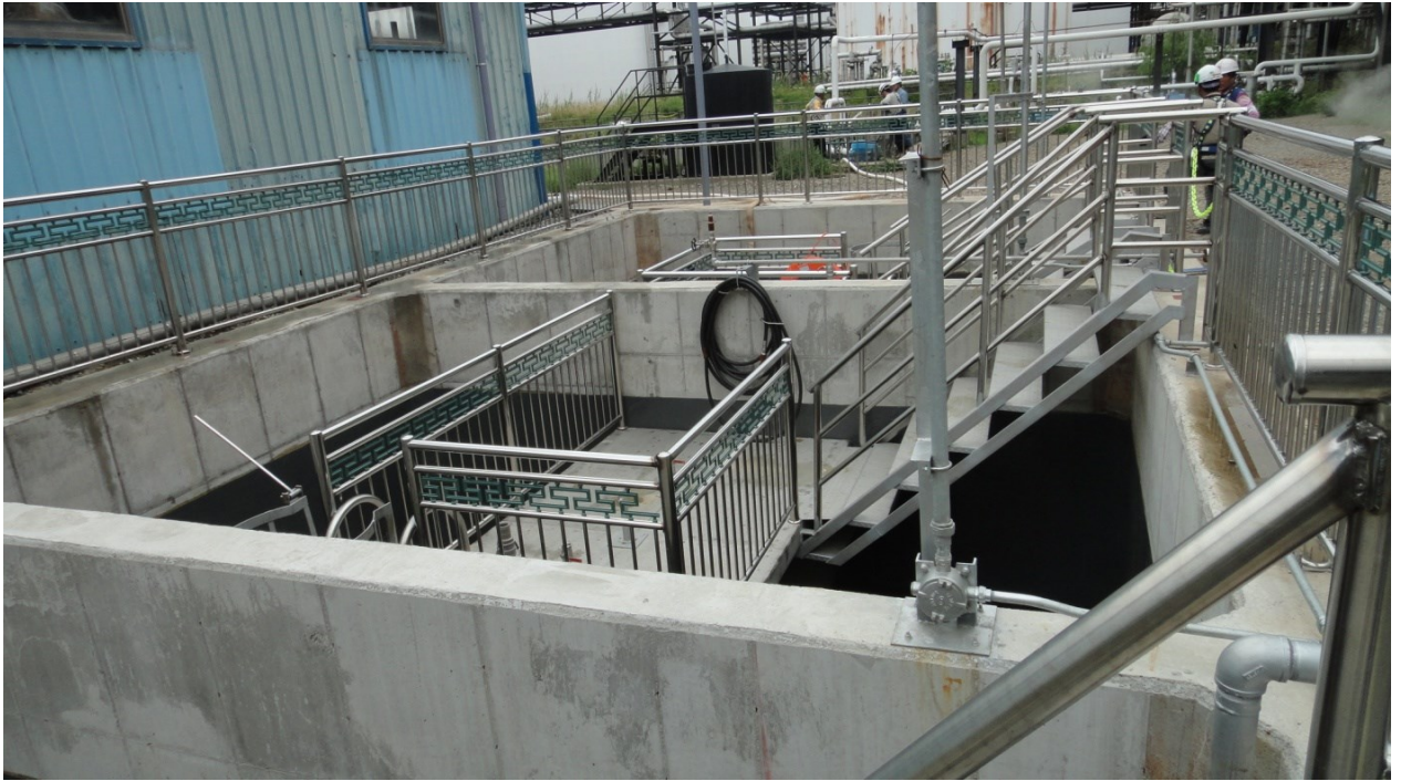
<AOS SEPARATOR 설치 전경>
