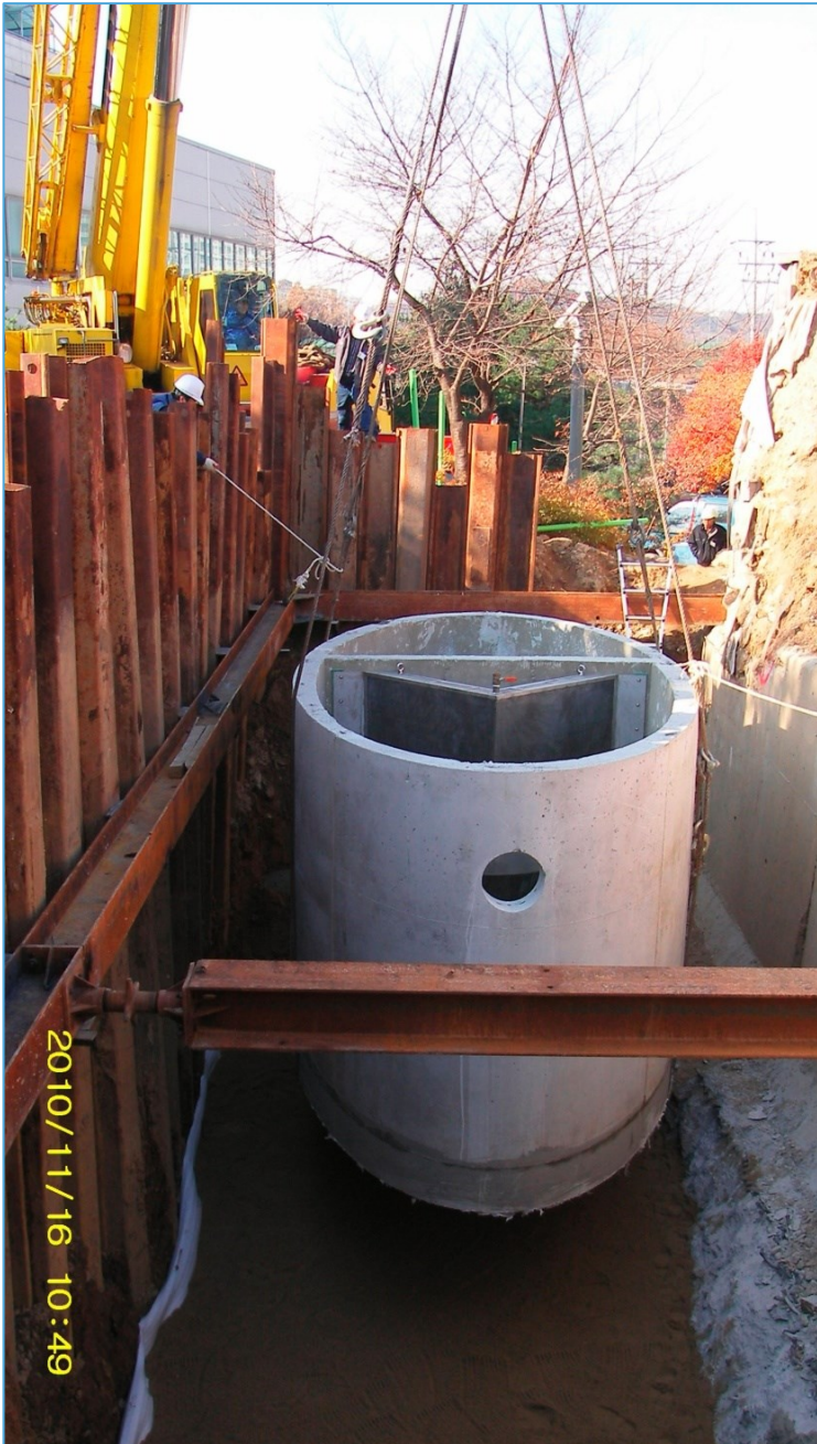
<처리시설 본체 설치>
