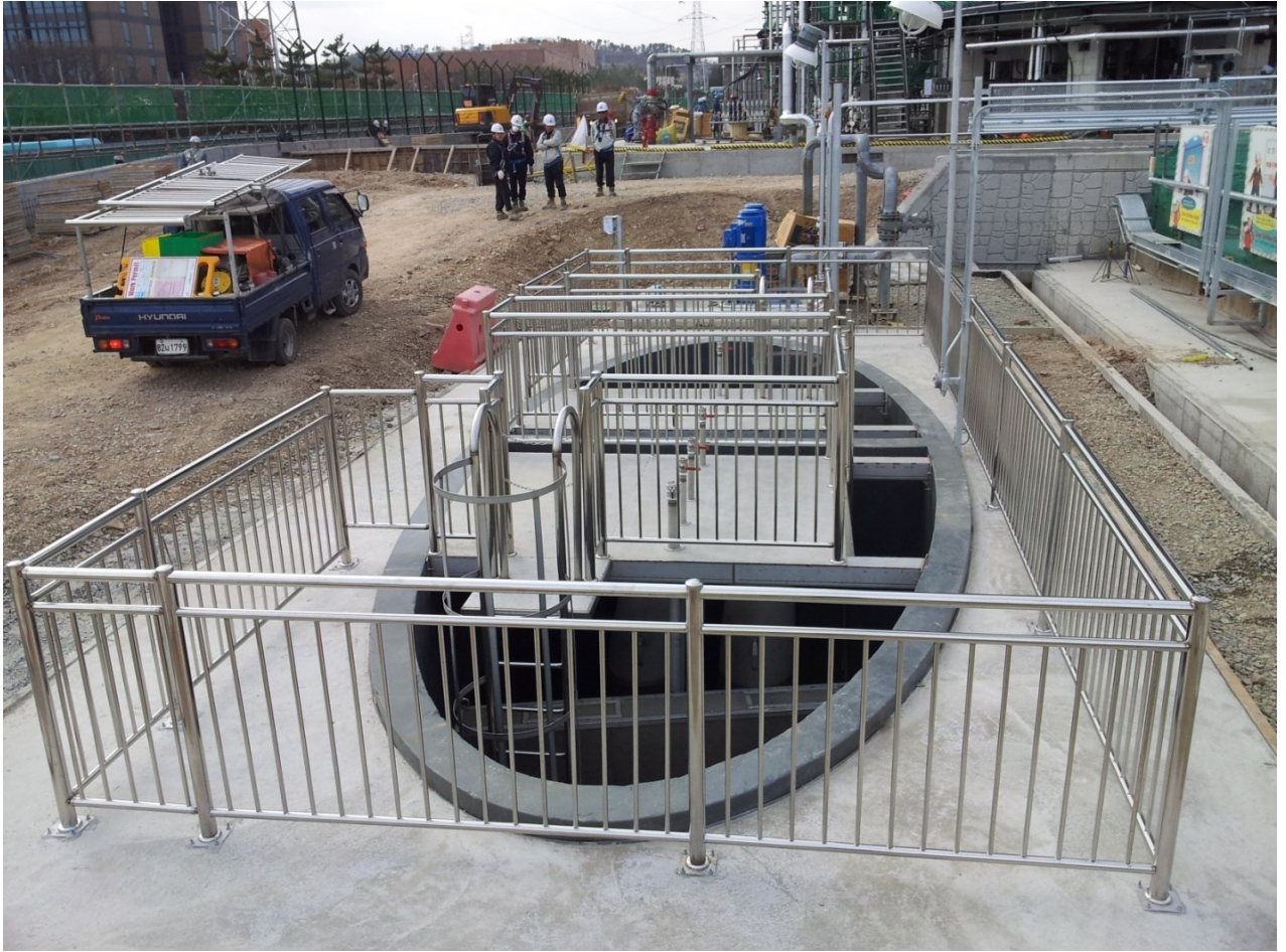
<AOS SEPARATOR 설치 전경>
