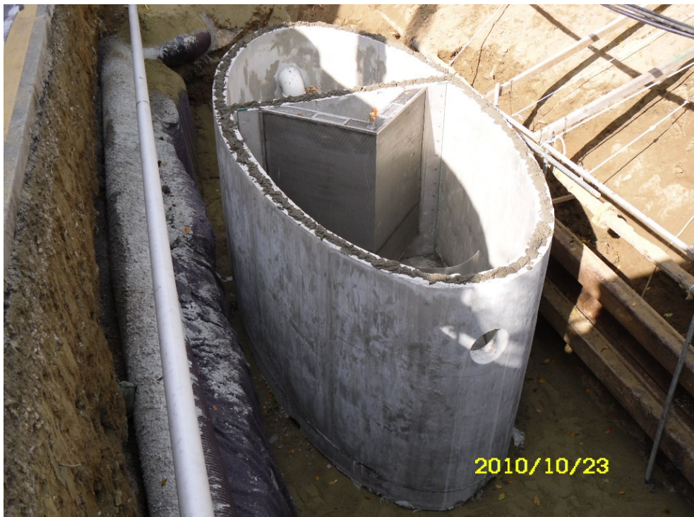
AOS SEPARATOR 시공장면
