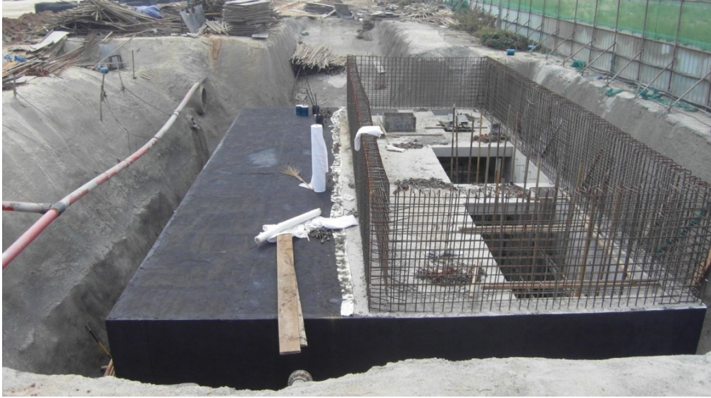
<AOS SEPARATOR 구조물 설치공사>
