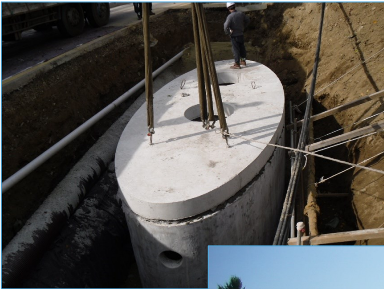
← <AOS SEPARATOR 설치 장면>
