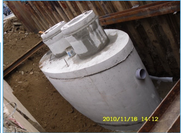
<점검구 설치 및 되메우기>
